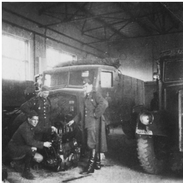
Oprava nákladných automobilov Tatra 27 v Divízijských autodielnách II
